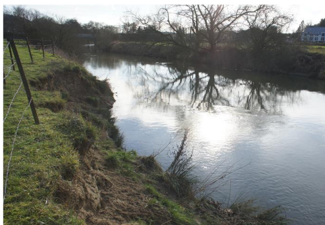
Foto gegen Fließrichtung
