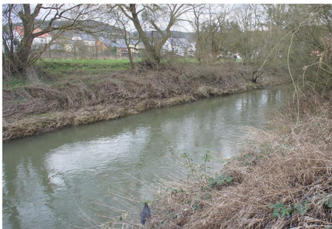
Foto gegen Fließrichtung
