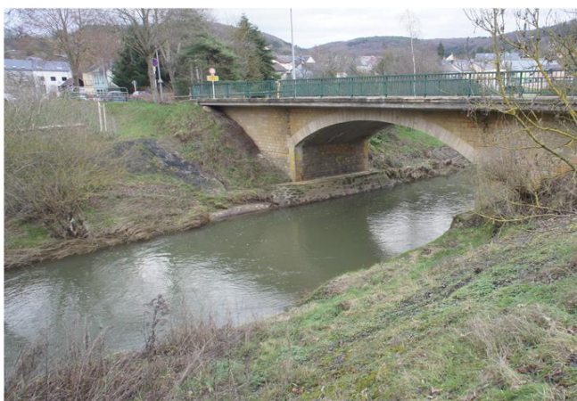
Foto gegen Fließrichtung
