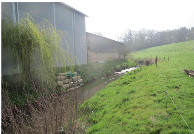
Foto gegen Fließrichtung
