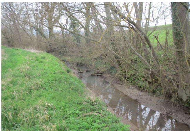
Foto gegen Fließrichtung
