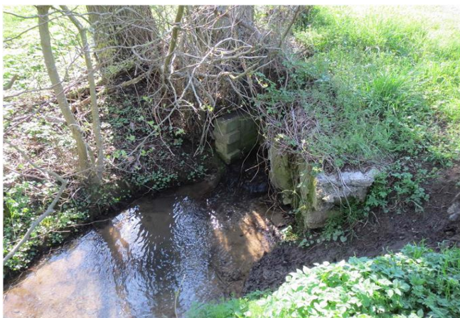
Foto gegen Fließrichtung
