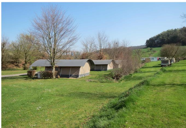
Foto gegen Fließrichtung
