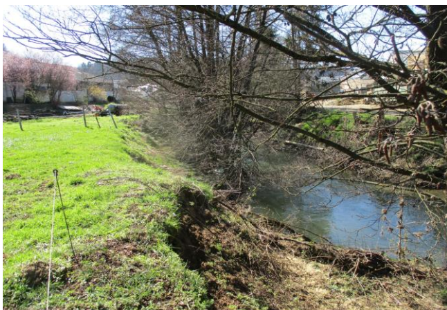
Foto gegen Fließrichtung
