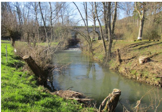
Foto gegen Fließrichtung
