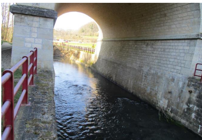
Foto gegen Fließrichtung
