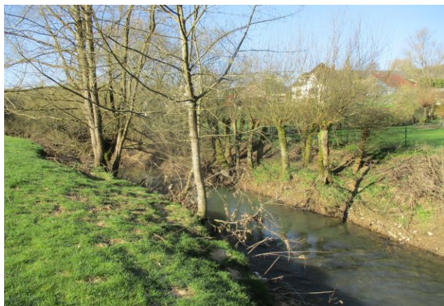
Foto gegen Fließrichtung
