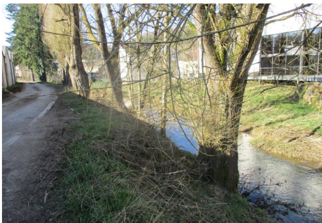
Foto gegen Fließrichtung
