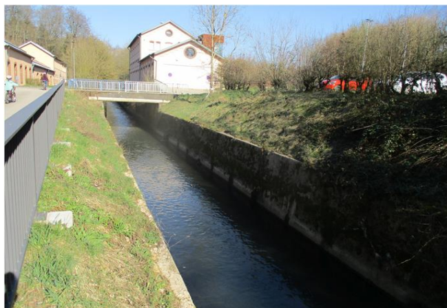
Foto gegen Fließrichtung
