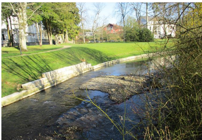
Foto gegen Fließrichtung
