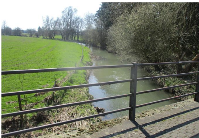
Foto gegen Fließrichtung
