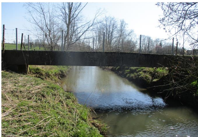
Foto gegen Fließrichtung
