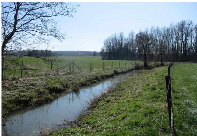
Foto gegen Fließrichtung
