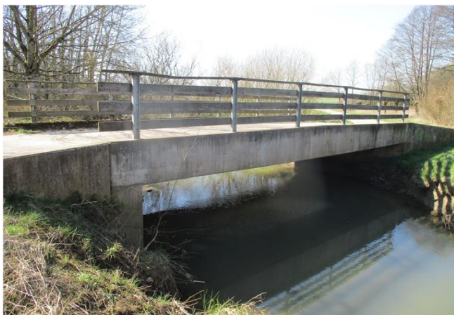
Foto gegen Fließrichtung
