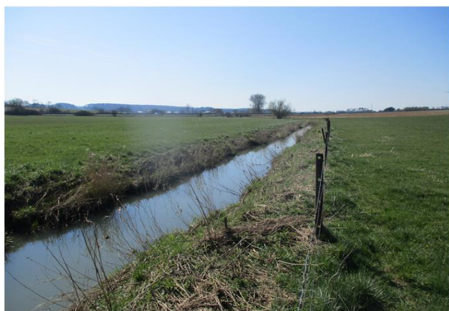
Foto gegen Fließrichtung
