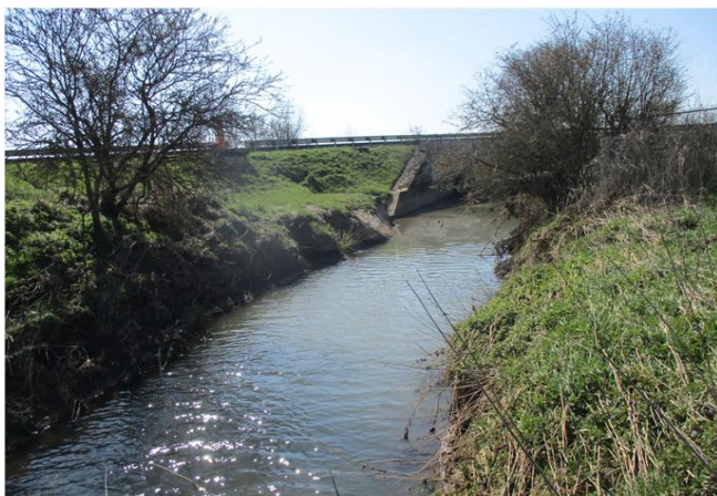
Foto gegen Fließrichtung
