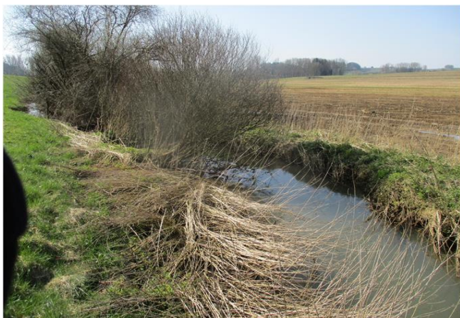
Foto gegen Fließrichtung
