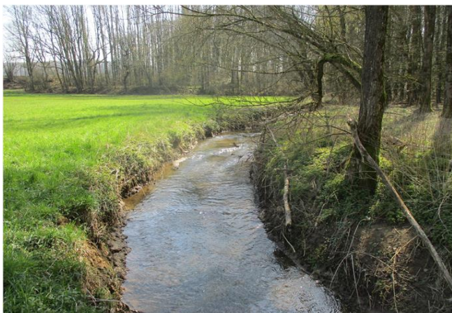
Foto gegen Fließrichtung
