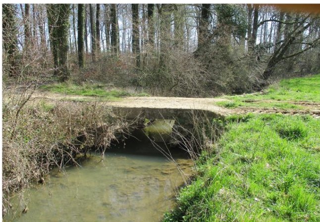
Foto gegen Fließrichtung
