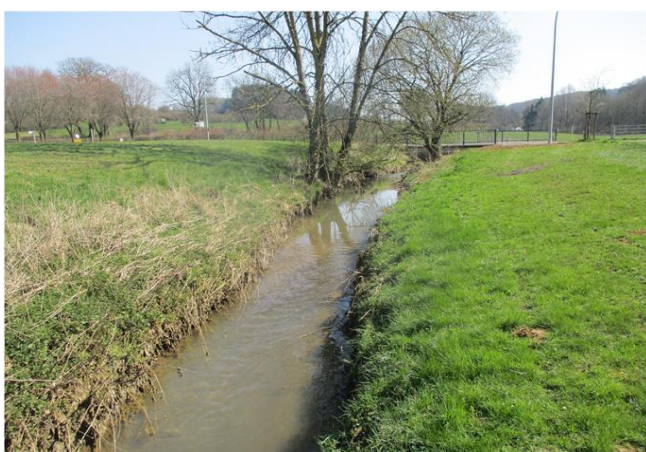
Foto gegen Fließrichtung
