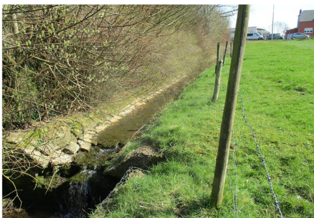
Foto gegen Fließrichtung
