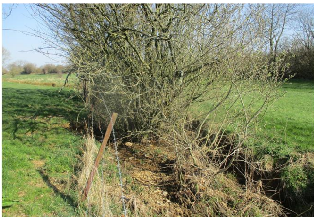
Foto gegen Fließrichtung
