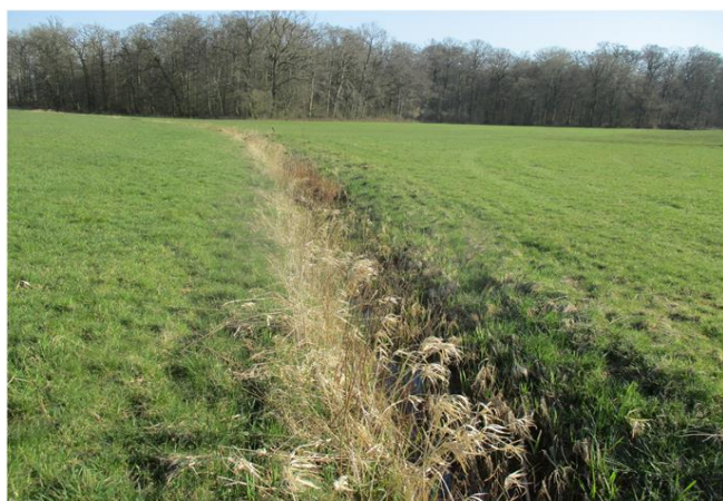
Foto gegen Fließrichtung
