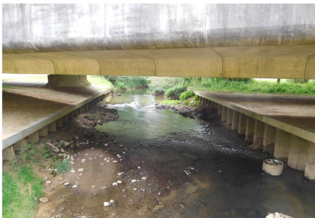
Foto gegen Fließrichtung
