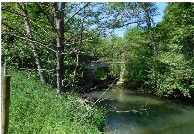
Foto gegen Fließrichtung
