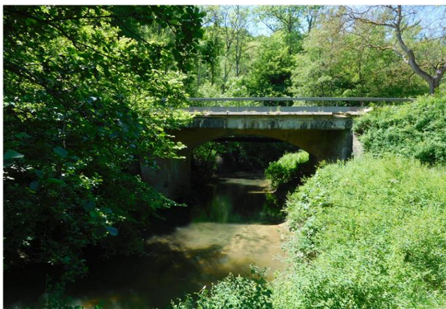
Foto gegen Fließrichtung
