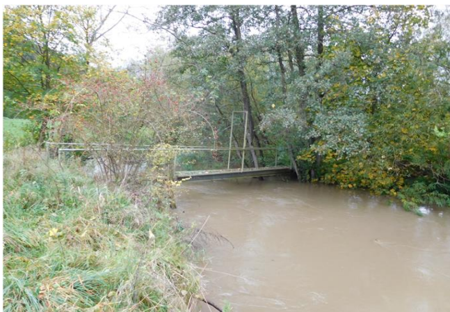
Foto gegen Fließrichtung
