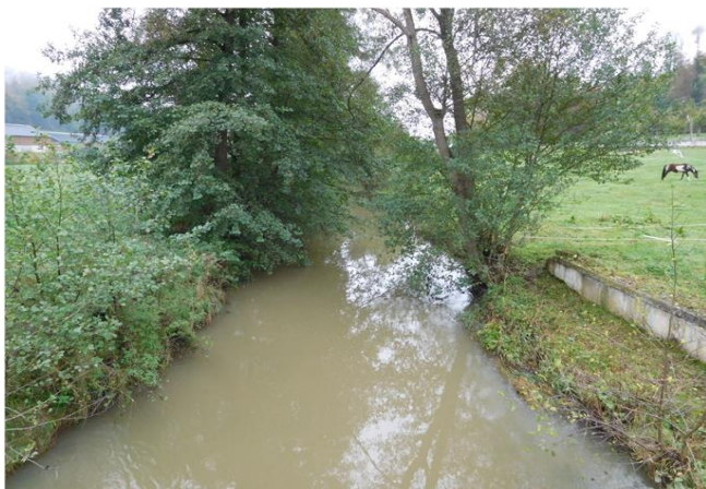
Foto gegen Fließrichtung
