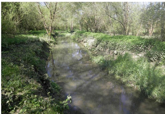
Foto gegen Fließrichtung
