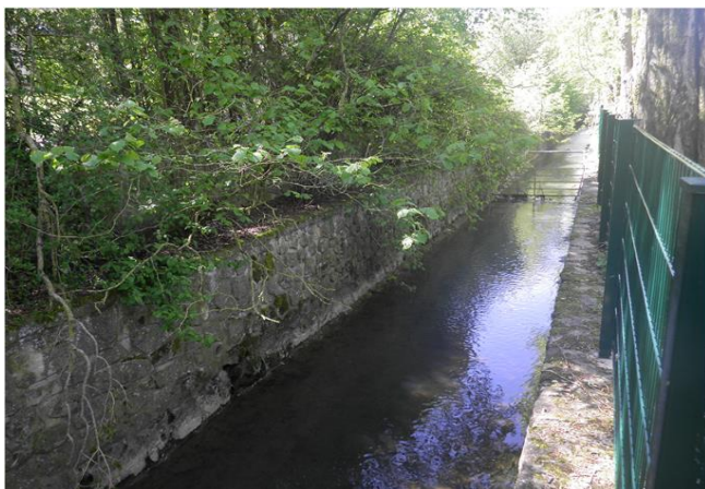
Foto gegen Fließrichtung
