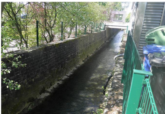
Foto gegen Fließrichtung
