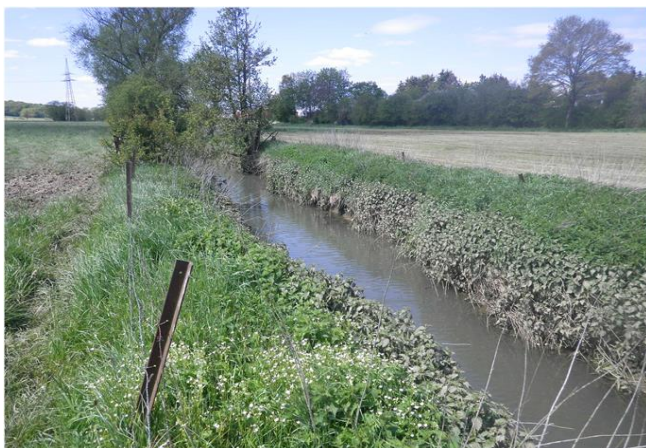
Foto gegen Fließrichtung
