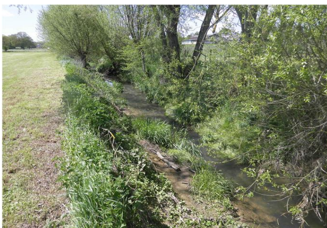
Foto gegen Fließrichtung
