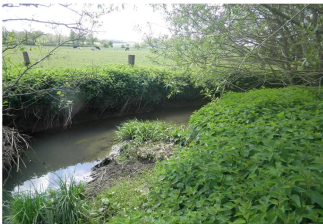
Foto gegen Fließrichtung
