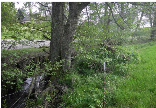
Foto gegen Fließrichtung
