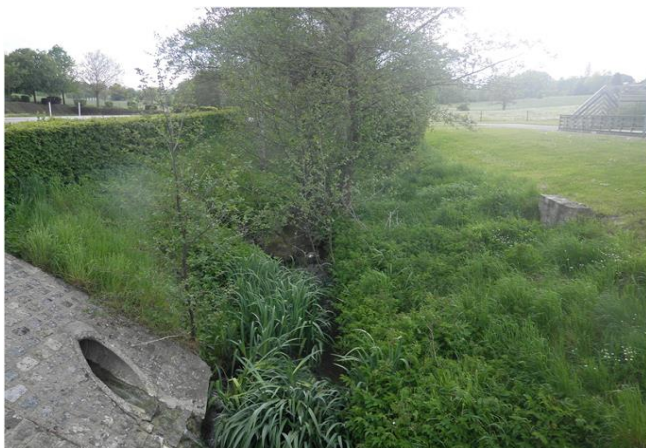
Foto gegen Fließrichtung
