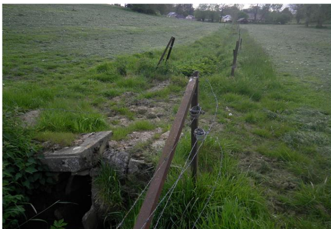
Foto gegen Fließrichtung
