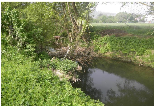
Foto gegen Fließrichtung
