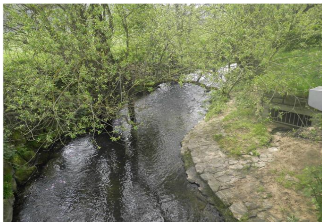
Foto gegen Fließrichtung
