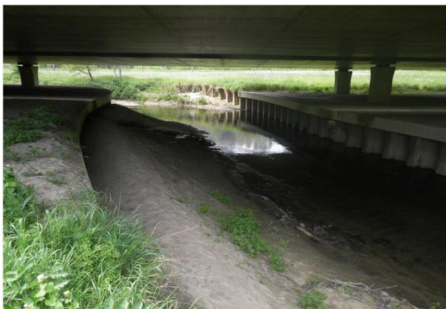
Foto gegen Fließrichtung
