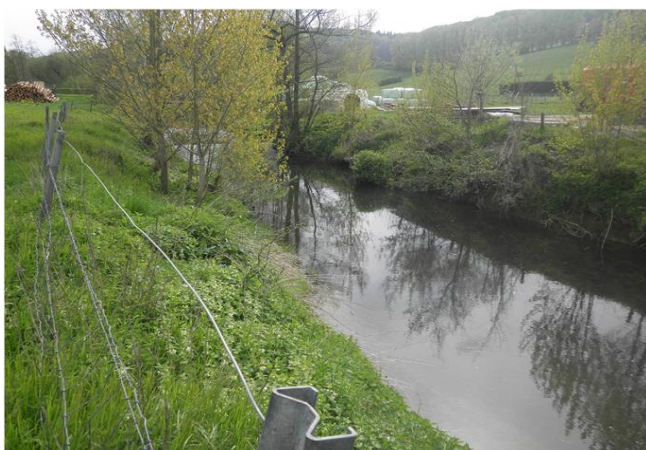
Foto gegen Fließrichtung
