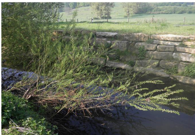
Foto gegen Fließrichtung
