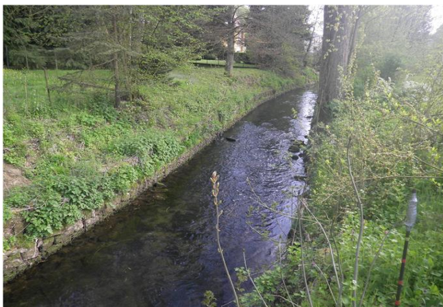
Foto gegen Fließrichtung
