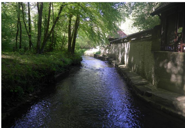
Foto gegen Fließrichtung
