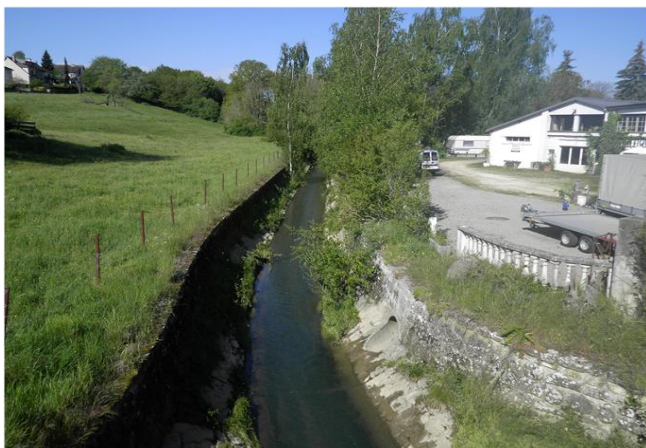
Foto gegen Fließrichtung
