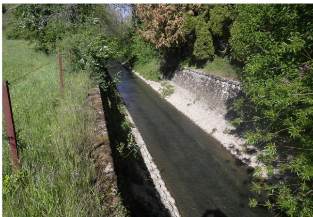
Foto gegen Fließrichtung
